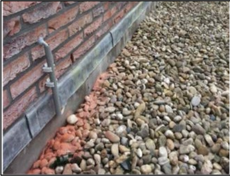
Figuur 3 Dakdoorvoer horizontaal
